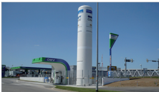
Abb. 2-3: Niederdruckspeicherung von Wasserstoff bei einer öffentlichen Tankstelle [Quelle: LindeGas]
