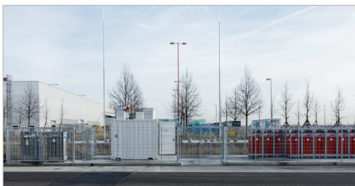
Abb. 2-4: Betankungsanlage und Hochdruckspeicher im H2IntraDrive Projekt
