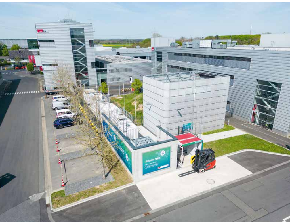
Abb. 1: H 2 -Station für BZ-Gabelstapler bei Linde Material Handling [Quelle: Linde MH]
