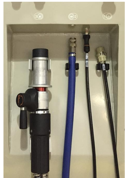
Abbildung 5: Chronologische Anordnung der Betankungskupplungen beim Plug Power-Dispenser
